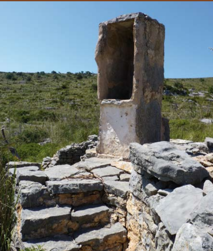
Coll de cisterna de Can Murtó (Foto: Gerard Bravo)
